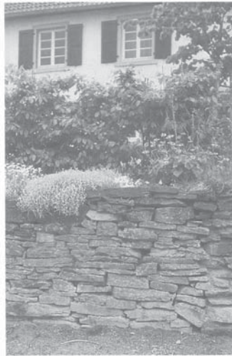
Ramscheid/Eifel, Alte Schule, Trockenmauer. Wenn diese Mauer nach jedem Winter ein wenig ins Lot geklopft wird, überdauert sie ein Jahrhundert.
