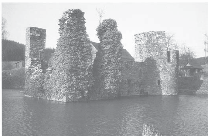
Lindlar, Burg Eibach. Ruinen müssen nicht wiederaufgebaut werden, um konserviert zu werden. Ihren Alterswert behalten sie nur bei Eingriffen, die das Ruinöse grundsätzlich hinnehmen.
