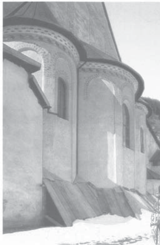
Müstair/GR, Kloster. Der einfache Schneeschutz verhindert die Durchfeuchtung der Wand und reduziert Schäden an den kostbaren Wandmalereien im Inneren.
