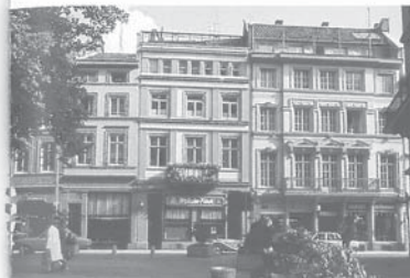
Aachen, Münsterplatz und Grafik »Hündlein«. Die angemessene Renovierung verschönert, ist Zeuge für weiterreichende Schutzbereitschaft und schafft damit wesentliche Erhaltungsvoraussetzungen.
