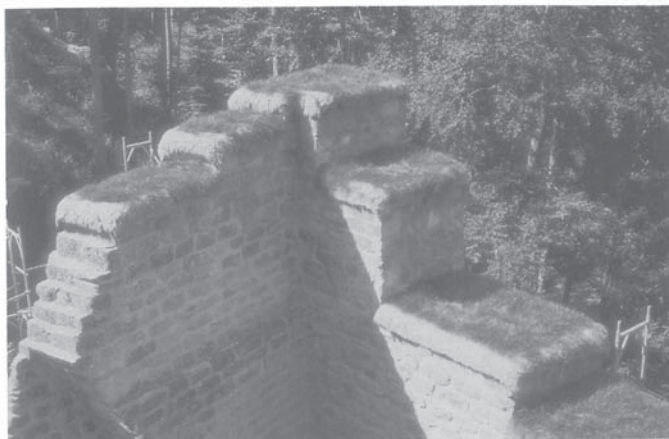
Grasburg/BE. Die Kronenabdeckung mit doppeltem Rasenbelag hat sich konservatorisch und ästhetisch bewährt.
