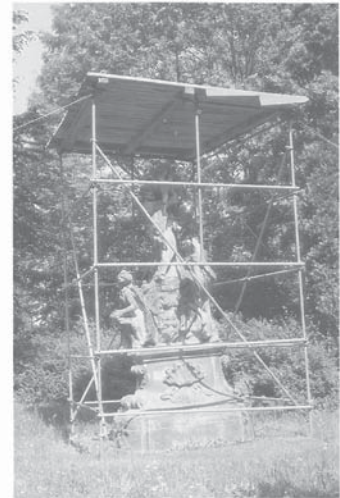
Schloß Seehof bei Bamberg, Figurengruppe im Park. Einfach, aber vorbildlich: provisorisches Schutzdach vor einer dauerhafteren Konsolidierung.
