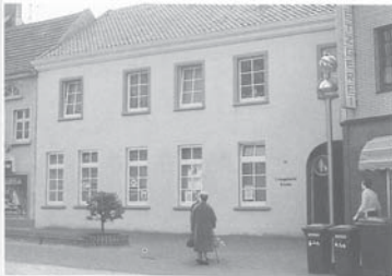
Kaldenkirchen, evangelisches Pfarrhaus. Leichtsinng führte zur Wiederaufbaunotwendigkeit: Während der Ausschachtung eines neuen Kellers rutschten die Umfassungsmauern in die Baugrube. Der Bau wurde unmittelbar wiederaufgebaut.
