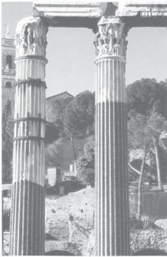
Rom, Trajansforum. Vorbildlich an dieser Wiederaufrichtung ist die Begrenztheit der Maßnahme und die Einfachheit der technischen Mittel.
