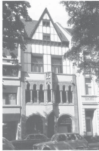
Krefeld, Westwall, Buschhüterhaus. Die Erhaltung am ursprünglichen Ort war wegen Straßenverbreiterung unmöglich. Die Bauweise – Hausteinsockel und Eisen-Glasfachwerk – machte eine Demontage und Umsetzung – um die Ecke – möglich.
